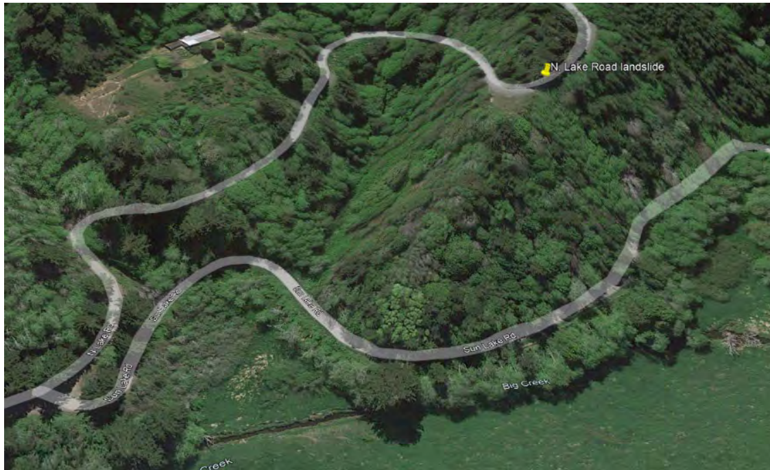
Figure I-27. N. Lake Rd Landslide Location
