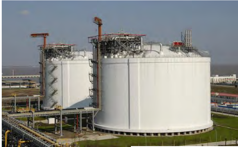
Shanghai Wuhaogou LNG Expansion Project two new 50,000 m3 LNG storage tanks.
